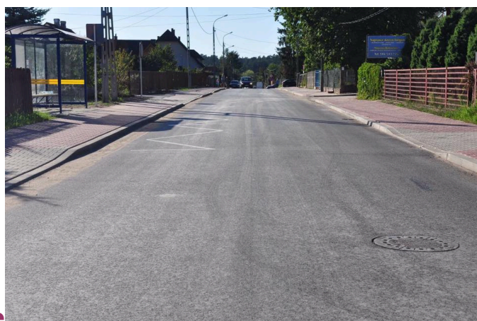
Południowa po przebudowie
